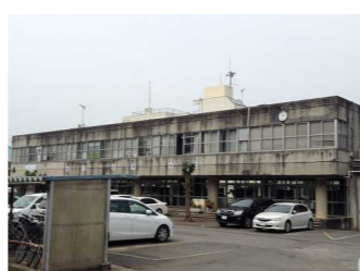
南門付近から見た管理棟
